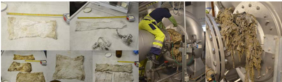
Abbildung1: Links: Vliestücher aus dem Berliner Kanalnetz, Probenahme BWB, Rechts: Mitarbeiter der BWB entfernt Materialansammlung aus einer Abwasserpumpe
