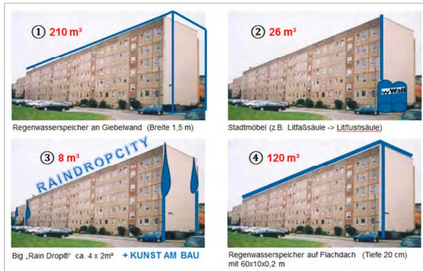
Abbildung 2: Möglichkeiten zur Sammlung und Speicherung des Spülmediums (u.a. Regenwasser) oberhalb Gelände [BWB]
