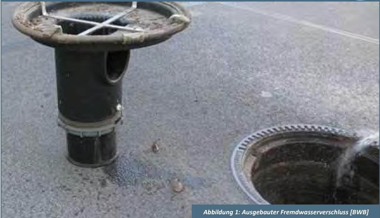
Abbildung 1: Ausgebauter Fremdwasserverschluss [BWB]
