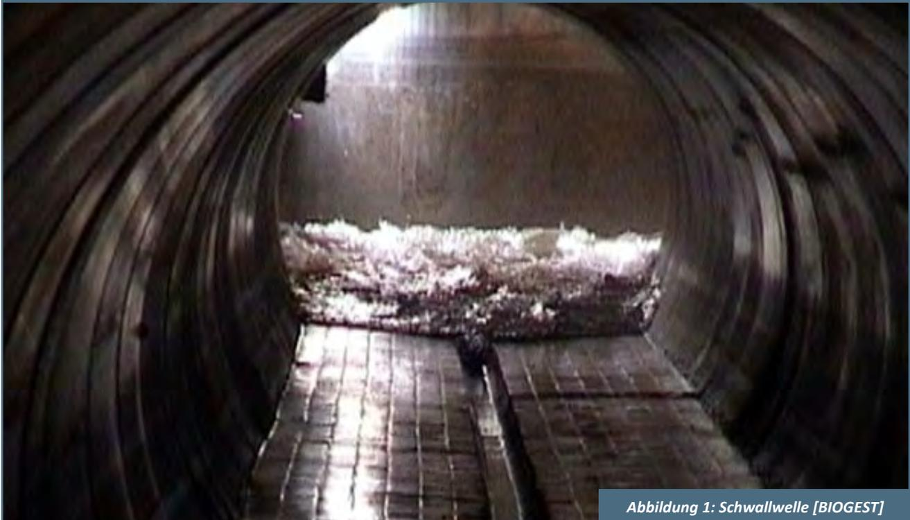
Abbildung 1: Schwallwelle [BIOGEST]
