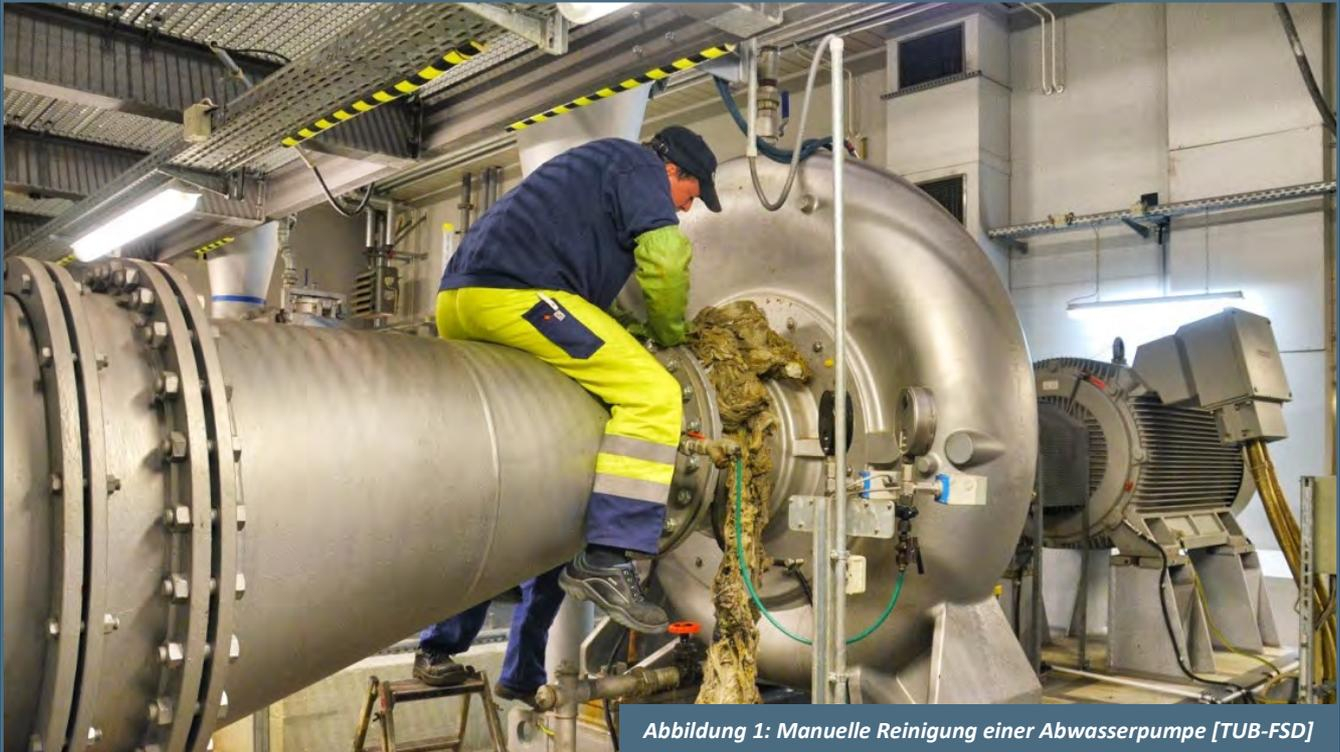
Abbildung 1: Manuelle Reinigung einer Abwasserpumpe [TUB-FSD]
