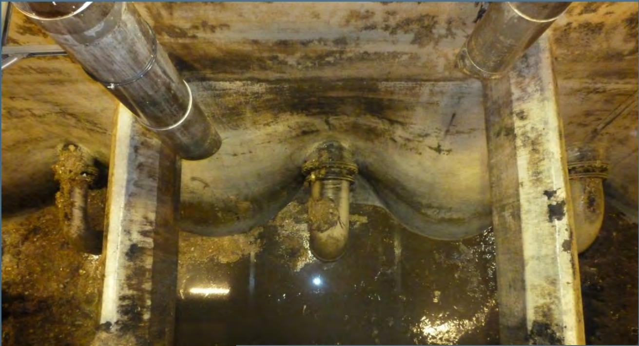
Abbildung 1: Saugraumoptimierung im HPw Biesdorf [TUB-FSD]
