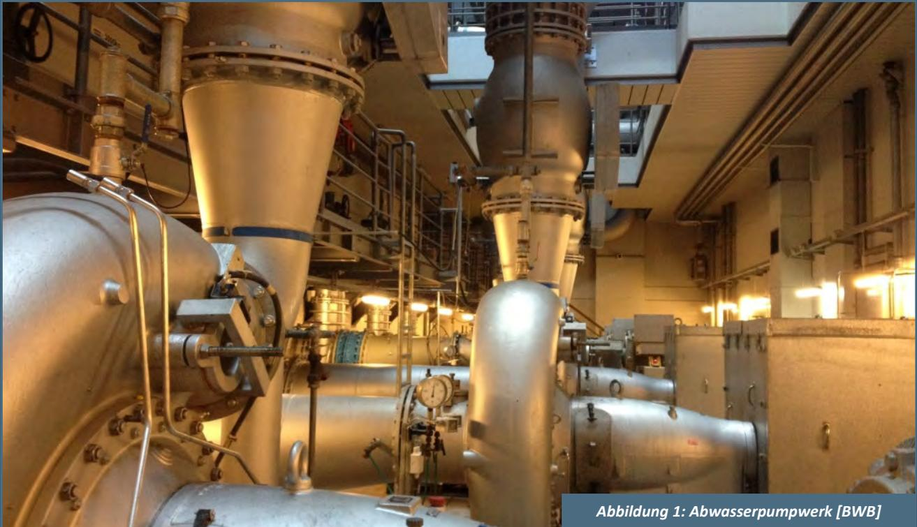
Abbildung 1: Abwasserpumpwerk [BWB]
