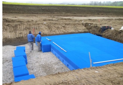
Bau einer Füllkörperrigole (Foto: Sieker)
