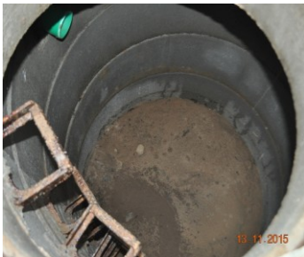
Blick auf die Sohle eines Sickerschachts (Foto: Sieker)
