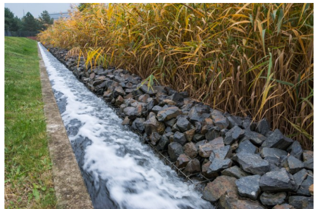
Retentionsbodenfilter Adlershof (Foto: Andreas Süß)
